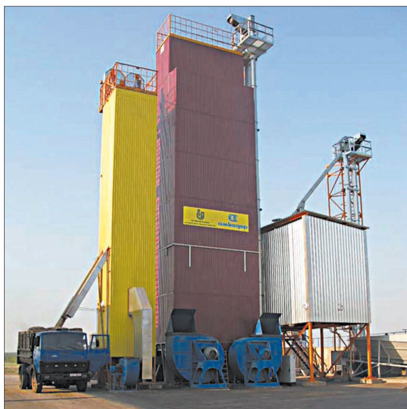
Зерноочистительно-сушильный комплекс ЗСК-30 обеспечивает комплексную механизацию сушки, очистки, погрузочно-разгрузочных работ
