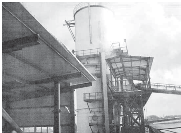
Колонный диффузионный аппарат мощностью 5,0 тыс. тонн переработки свеклы в сутки фирмы БМА (Германия), впервые на Кубани освоенный в ЗАО «Успенский сахарник»
