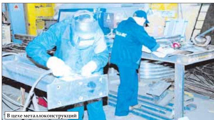
В цехе металлоконструкций
