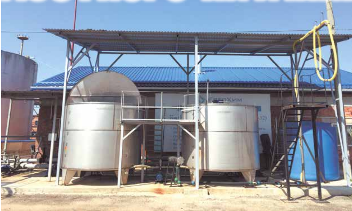
В марте 2016 г. ООО «Агроцентр ЕвроХим Краснодар» ОСП в г. Усть-Лабинске запустило в работу узел смешения КАС с сульфатом аммония
