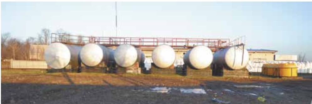
Новый блок ЖКУ, ст. Каневская
