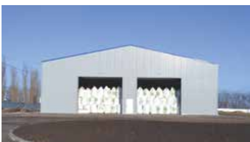
Склад минеральных удобрений, ст. Выселки
